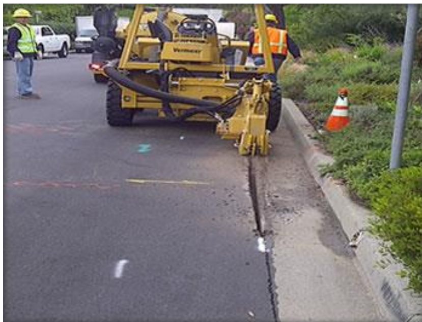
Slika 25 Primjer br. 2 kopnenih građevinskih radova
