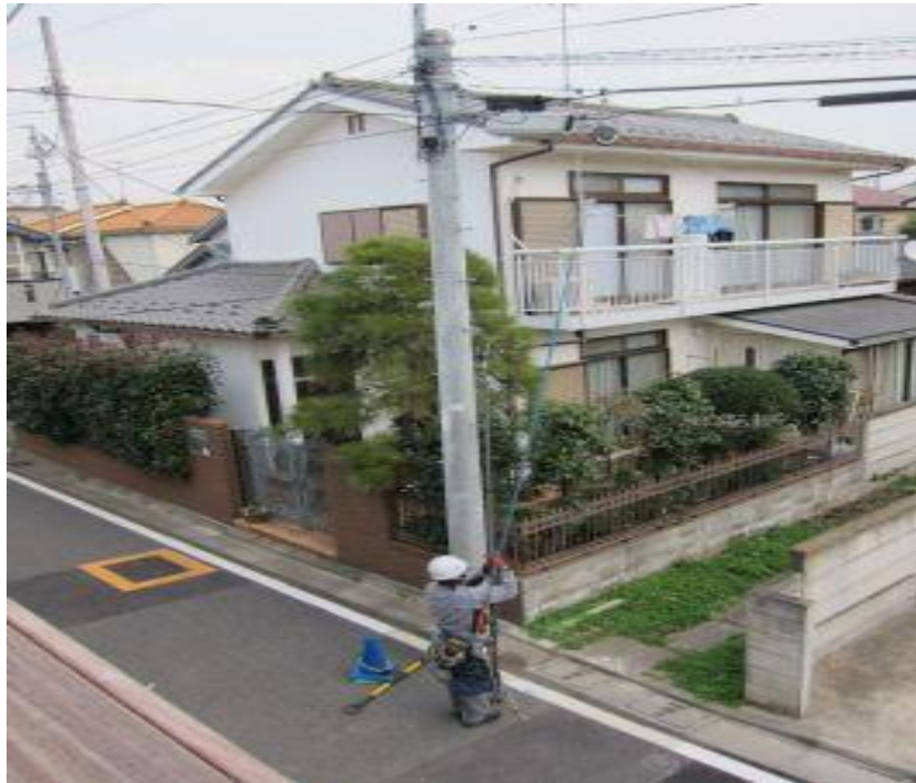
Slika 27 Primjer postavljanje svjetlovodnih kabela putem nadzemne mreže
