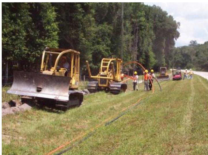
Slika 24 Primjer br. 1 kopnenih građevinskih radova
