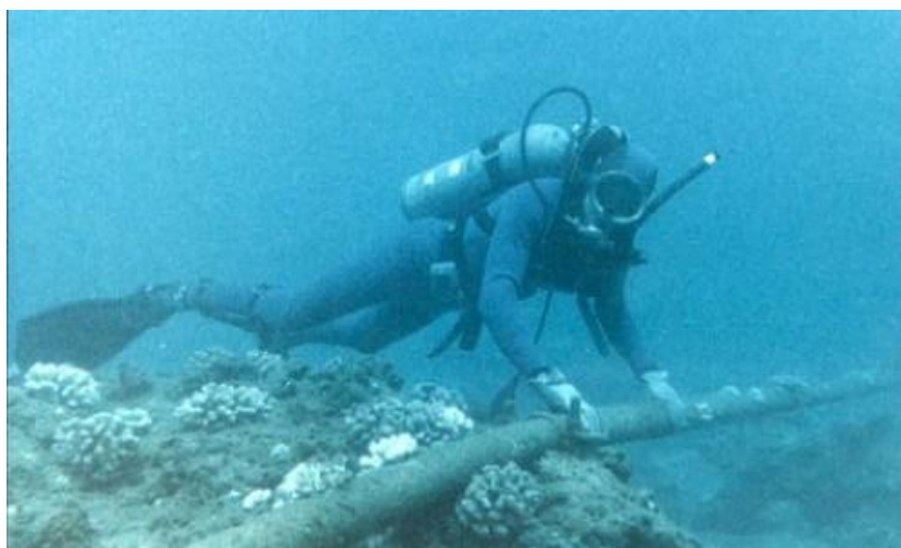
Slika 26 Primjer polaganja (sidrenja) kabela telekomunikacijske infrastrukture na dno mora
