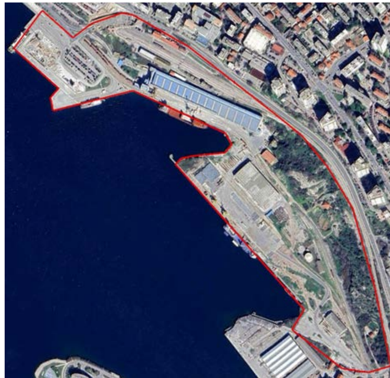
Slika 8-23. Pogled iz zraka na željezničku stanicu Šibenik (Izvor: geoportal.dgu.hr, Oikon)
