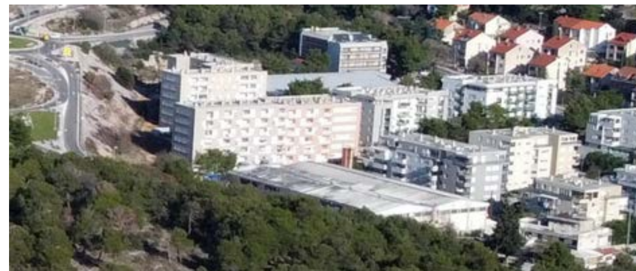
Slika 8-48. Pogled iz zraka na dio naselja Šubičevac (Izvor: Oikon)
