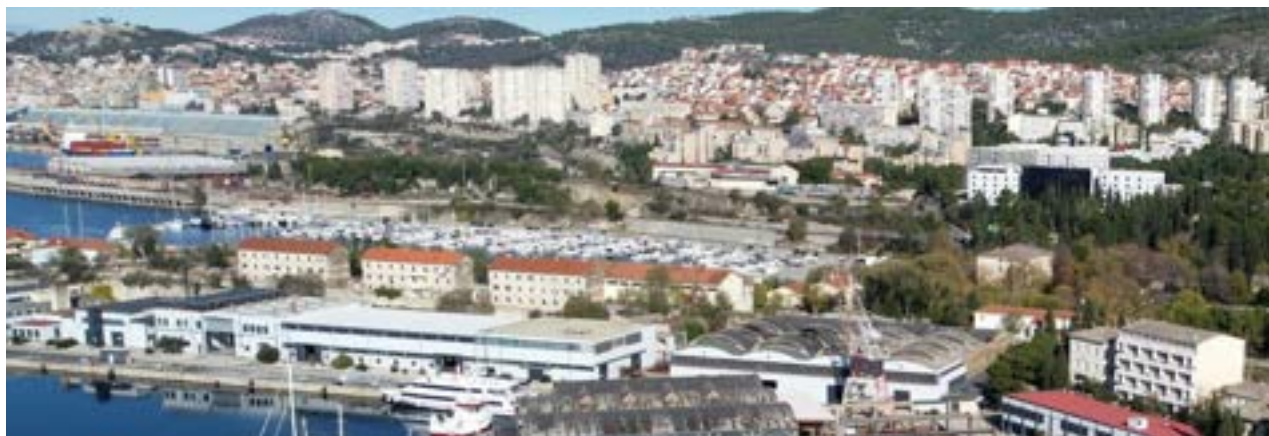
Slika 8-24. Pogled iz zraka na željezničku stanicu Šibenik (Izvor: Oikon)
