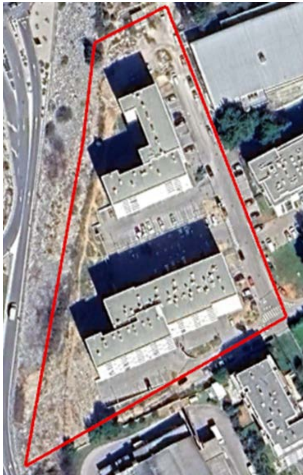
Slika 8-47. Pogled iz zraka na dio naselja Šubičevac. (Izvor: geoportal.dgu.hr, Oikon)
