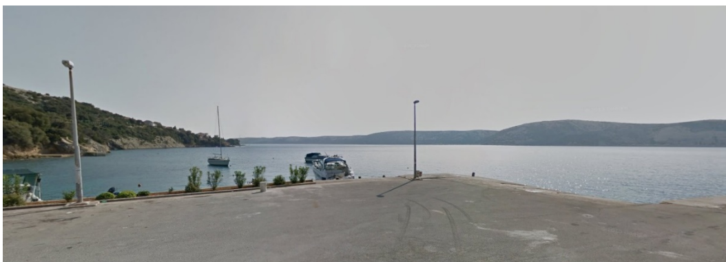
Slika 39 Ro-ro rampa u luci Drljanda (Izvor: www.google.hr )
